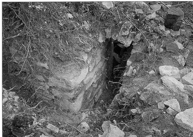
Abb. 1 Beinwil/Glashütte Waldenstein. Das auf der Südseite mit Sandsteinquadern verblendete Gewölbe und die Mauerecke des Gebäudes von Nordwesten.
