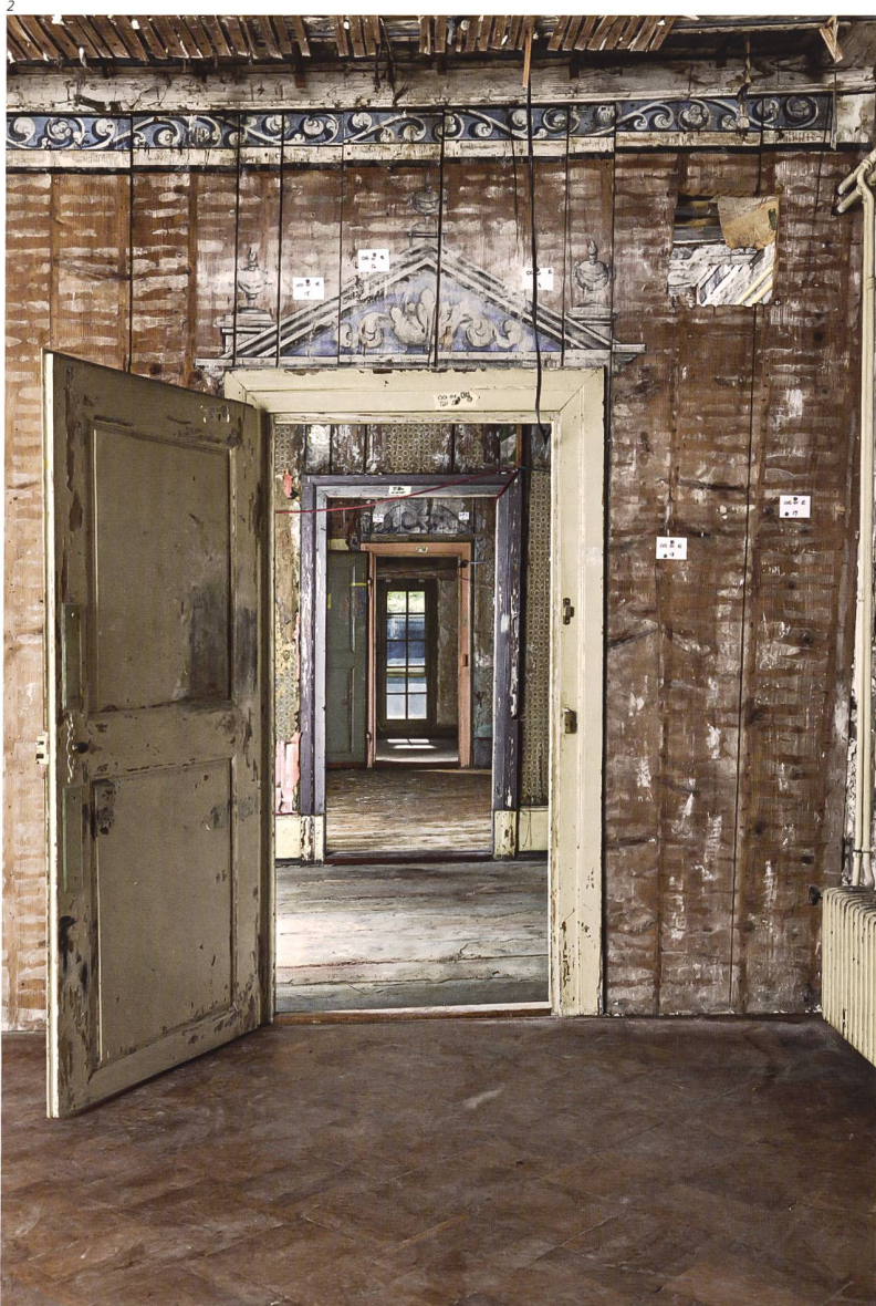
Abb. 2 Subingen, Vigier-Schlössli. Blick durch die Zimmerflucht des Obergeschosses.
