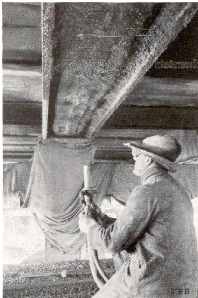
Fig. 3 Gunitage des membrures inférieures
