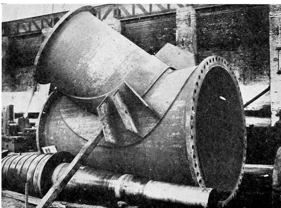
Fig. 1. Réalisation par soudure d'un embranchement de tuyauterie, conforme aux résultats d'une étude tensiométrique d'un modèle, à l'échelle 1/5<sup>e</sup>, soudé.
