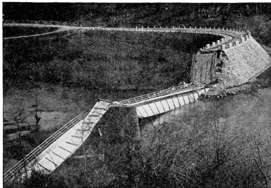
Abb. 3. Mreschnitzbrücke nach der Sprengung
