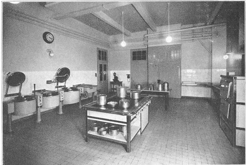
Fig. 4. — Cuisine électrique de l'Imprimerie St-Paul, à Fribourg.
