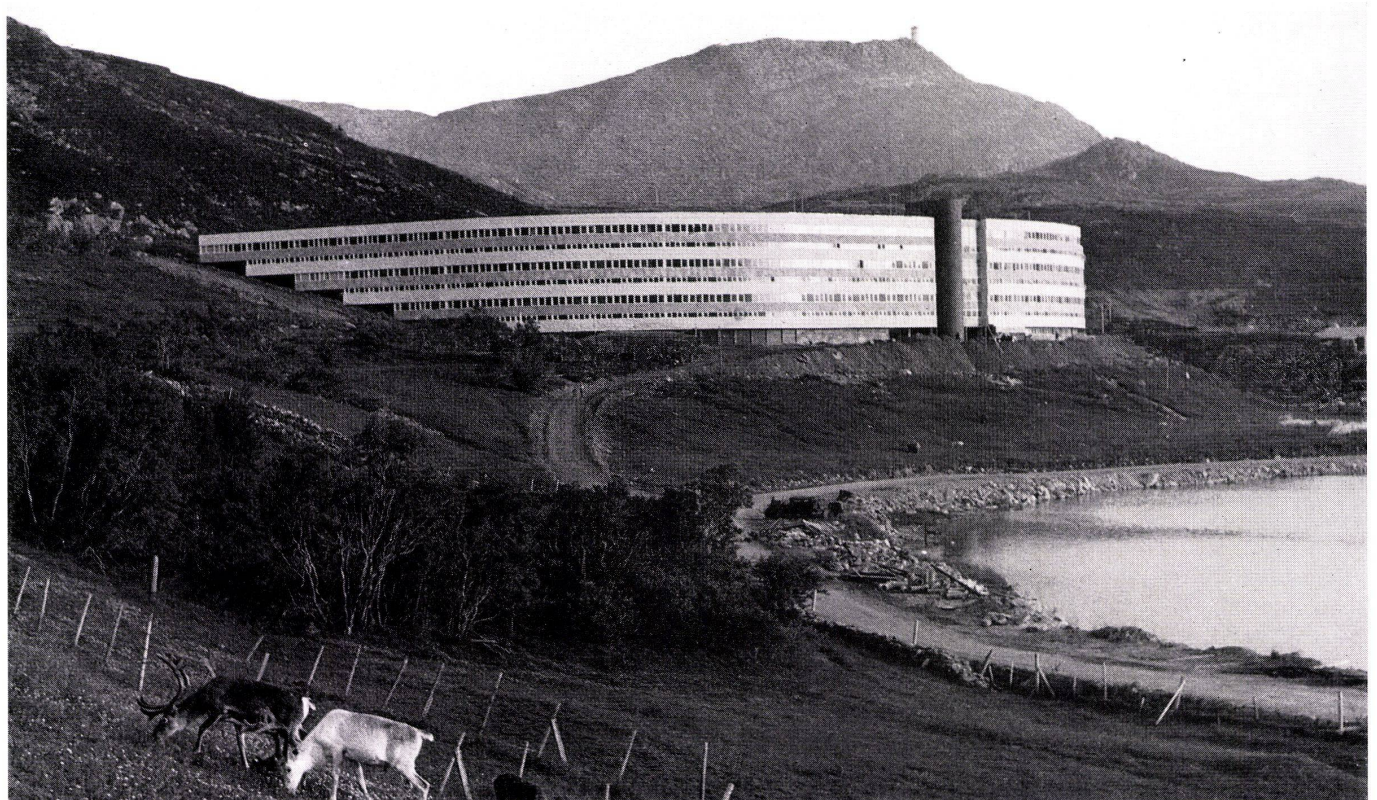
Ansicht von Süden. Vue depuis le sud. View from south.
