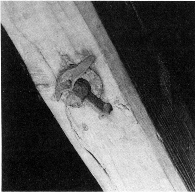
Abb. 7. Der Splint diente auch beim Bau des Rades als einfaches, aber solides Verbindungsmittel, das leicht anzuwenden war. Im Bedarfsfalle konnte es wieder gelöst werden.
