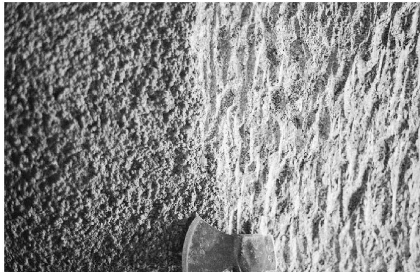
Abb. 10 Spritzbetonoberfläche, spritzrau (links) und nach dem Behauen. Foto: Laich SA, Avegno
