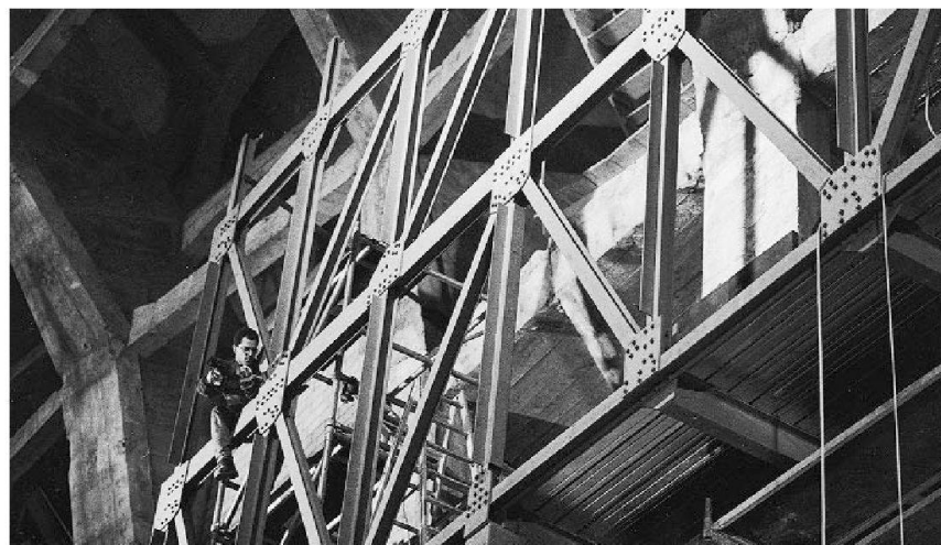
Abb. 4 Montage der Tragkonstruktion.
