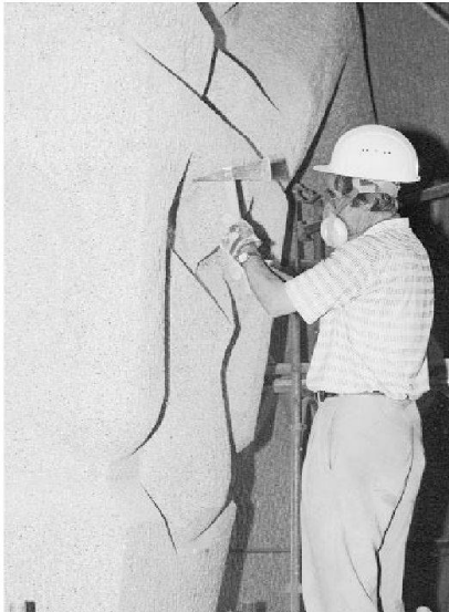
Abb. 11 Feinbearbeitung der Spritzbetonoberfläche durch einen Bildhauer.
