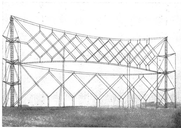
Fig. 6. Strahlwerfer von Chireix-Mesny der SFR.
