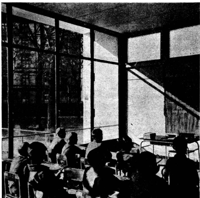
**Bon éclairage :** La surface des fenêtres comporte au moins la moitié ou le tiers de la surface de la classe. Pas de couverte, donc bon éclairage du plafond et bonne ventilation. Impression de plein air.
