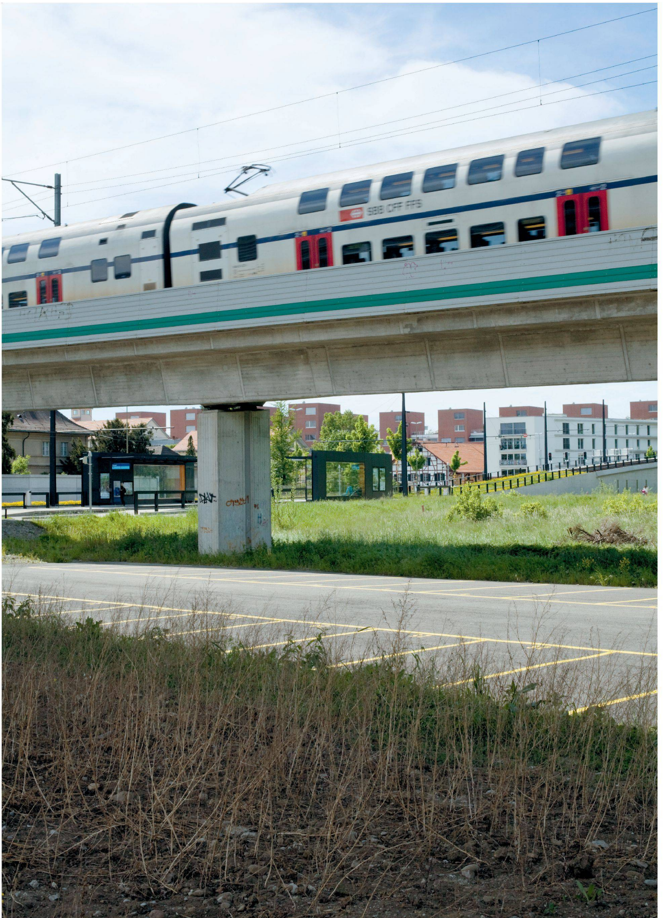
Die Glattalbahn – hier unter der S-Bahn beim Neugut – hat viele Verbindungen geschaffen: von Haltestellen, Gemeinden, Verkehrsbetrieben und Planern.
