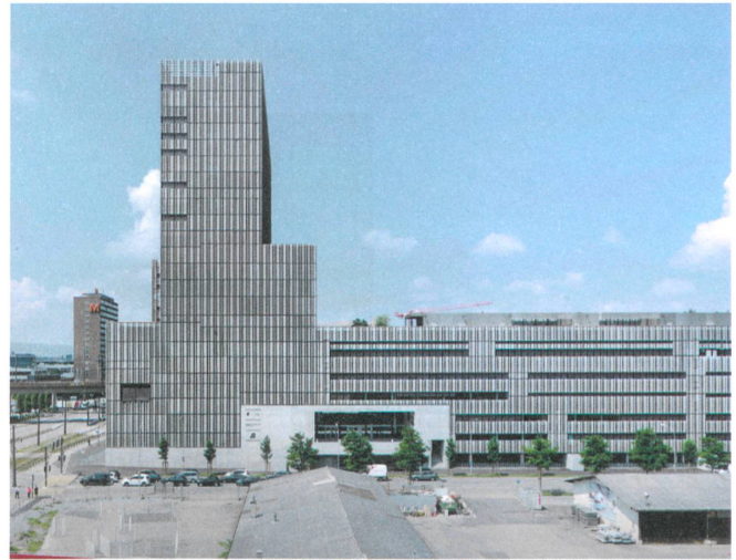
5 Toni-Areal: Das Wohnhochhaus über einem Sockelbau mit Dachterrasse ist ein interessanter Typus für das postindustrielle Entwicklungsgebiet. Foto: Simon Menges
