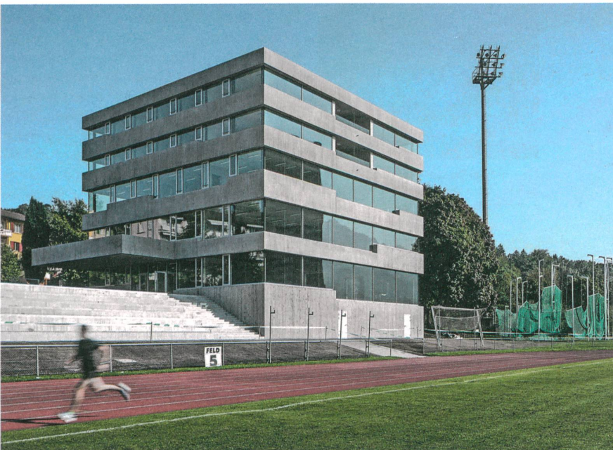
Sorgfältig geschalter Sichtbeton und viel Glas mit schlanken Metallfassungen prägen die Fassade.
