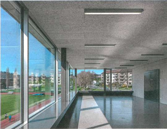
Mit einem klaren Stützenraster antworten die Architekten Lütolf und Scheuner auf die unterschiedlichen Nutzungsansprüche.
