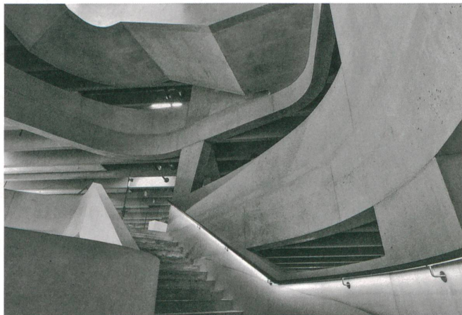
Eine Betonplastik als Treppe vom Erdgeschoss ins dritte Obergeschoss.
