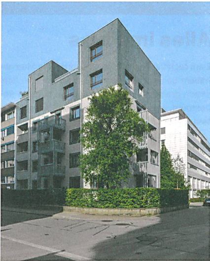
Die zinnenhafte Aufstockung im Plättli- und Holzblech verleiht dem Haus wieder Kraft.
