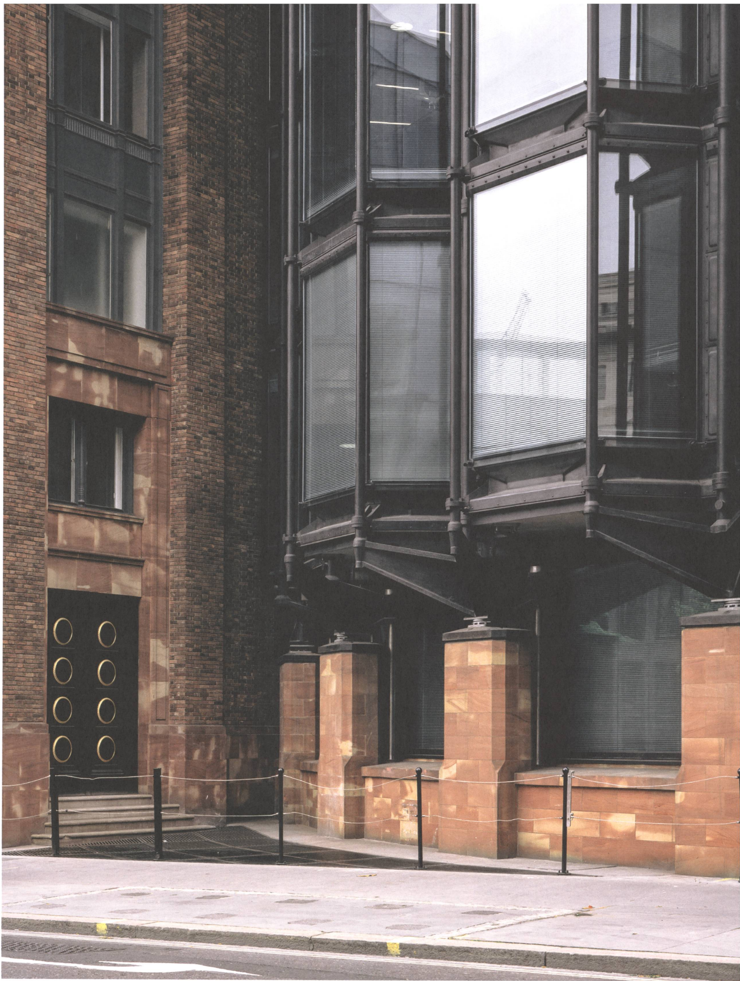
Das Bracken House (1987–1992) der Financial Times : Der neue Teil aus Sandsteinsockel, Bronze und Glas ergänzt zwei alte Flügel aus den 1950er-Jahren.
