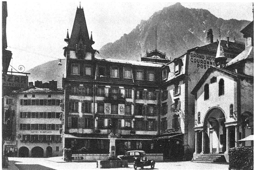
Abb. 7. Brig. Hotel «Couronnes et Poste» nach dem teilweisen Abbruch von 1935 (nach einer Aufnahme von Edition Phot. Perrochet, Lausanne) (vgl. Abb. 2)
