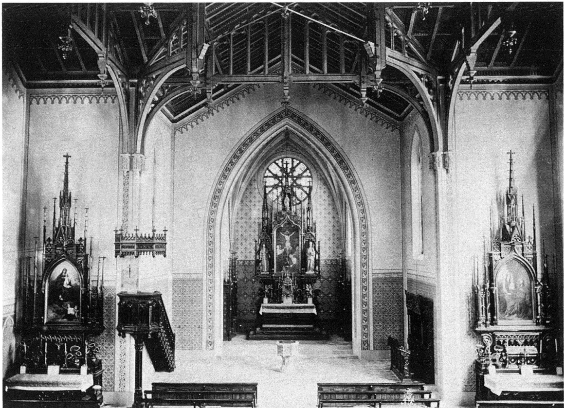
Abb. 1. Lichtensteig. Ehemalige paritätische Kirche St. Gallus, 1867/68 von Johann Christoph Kunkler erbaut. Zeitgenössisches neugotisches Mobiliar aus der Werkstatt der Gebrüder Müller, Wil, mit Altarbildern von Severin Benz, München. Kirche 1968 abgebrochen, Ausstattung vernichtet
