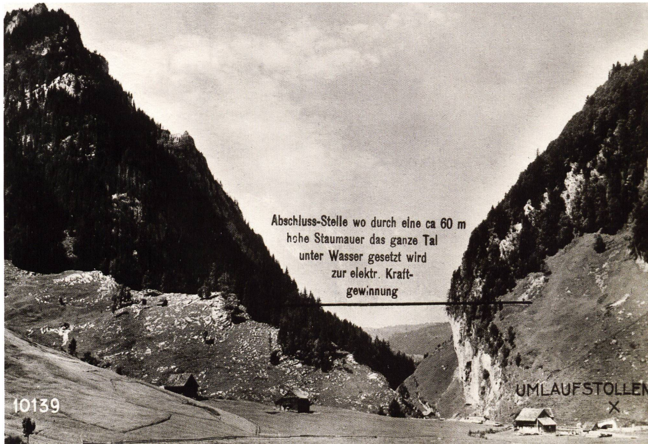
Der Schräh-Engpass bot sich als geeignete Stelle für den Bau einer Staumauer an. Die eingezeichnete Linie markiert die Krone der später erstellten, 66 Meter hohen Staumauer.
