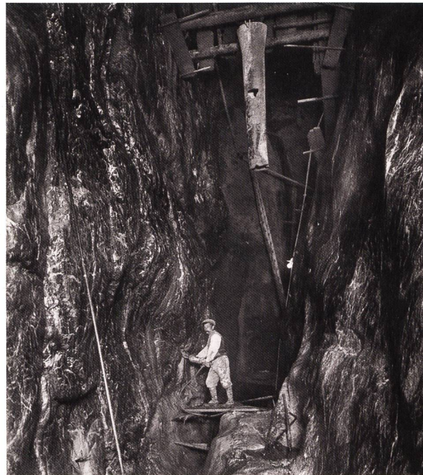
Für eine solide Fundierung der Staumauer im festen Fels waren im Schräh umfangreiche Aushubarbeiten notwendig.
