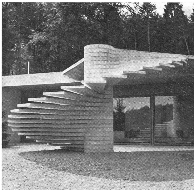
La scala a chiocciola costruita in elementi prefabbricati: costituisce il collegamento principale fra il terrazzo esterno all'altezza della galleria e l'atrio.
