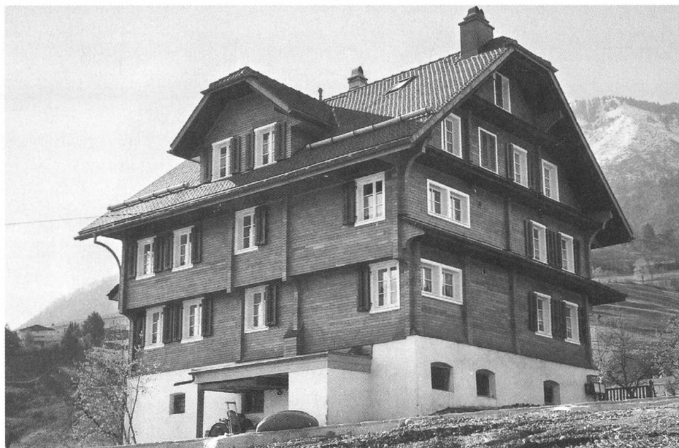
Ennetmoos, Bauernhaus Hostatt. Ansicht von Nordosten. Zustand nach der Restaurierung
