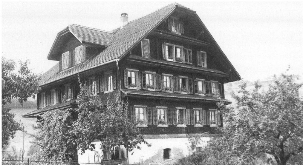
Ennetmoos, Bauernhaus Hostatt. Ansicht von Süden. Zustand vor der Restaurierung
