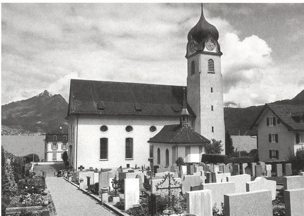
Beckenried, Pfarrkirche St. Heinrich, Aussenansicht von Süden. Zustand vor der Restaurierung.
