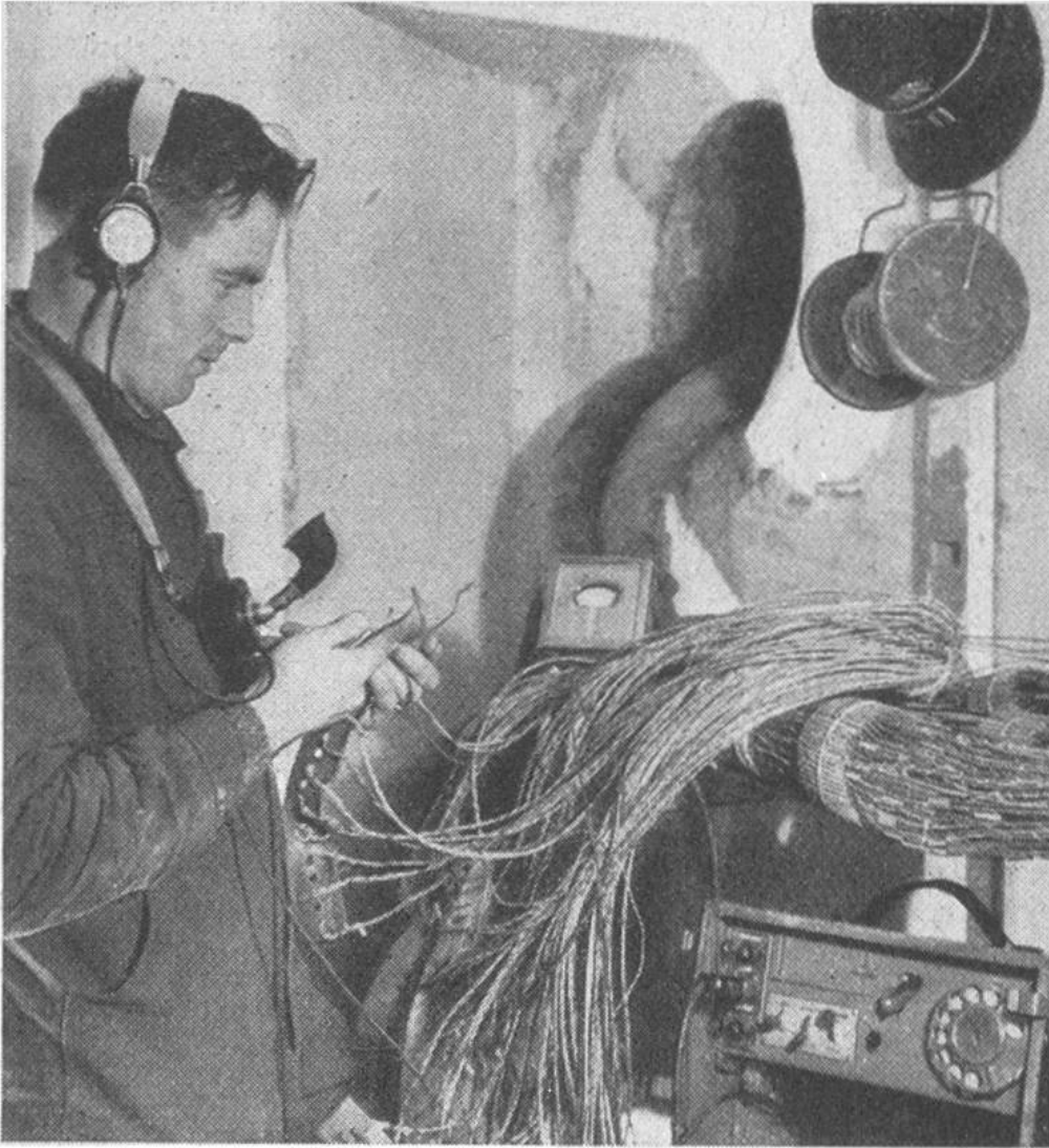
K a b e l s p l e i s s e n (Zusammensetzen zweier Kabelstücke) in einem unterirdischen Kabelstollen.
