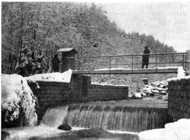
Abb. 3. Wassermessstation mit Limnigraph und Meßsteg im Val Ferret.
