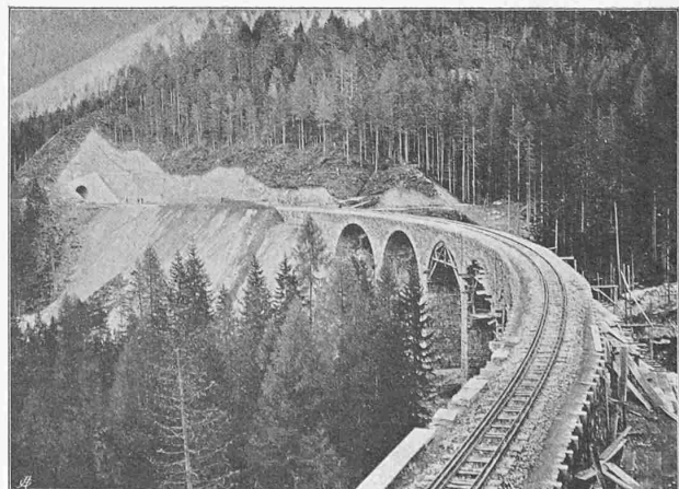
Abb. 15. Cavia-Viadukt, taleinwärts gesehen. Steilgeböschter Tunnel-Voreinschnitt in der Rauhacke.
