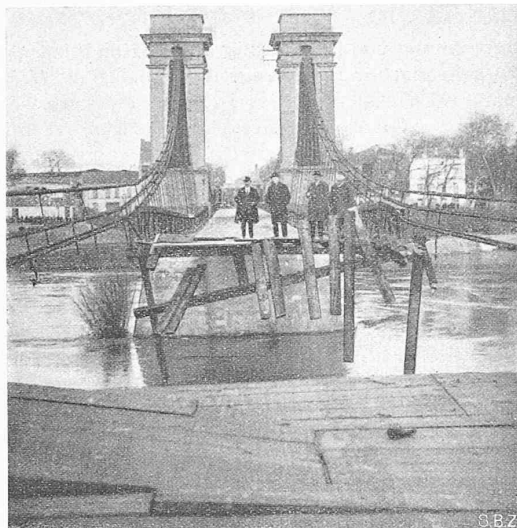
Durchbruch der Fahrbahn an der Hängebrücke über die Garonne bei Marmande in Südwest-Frankreich.
