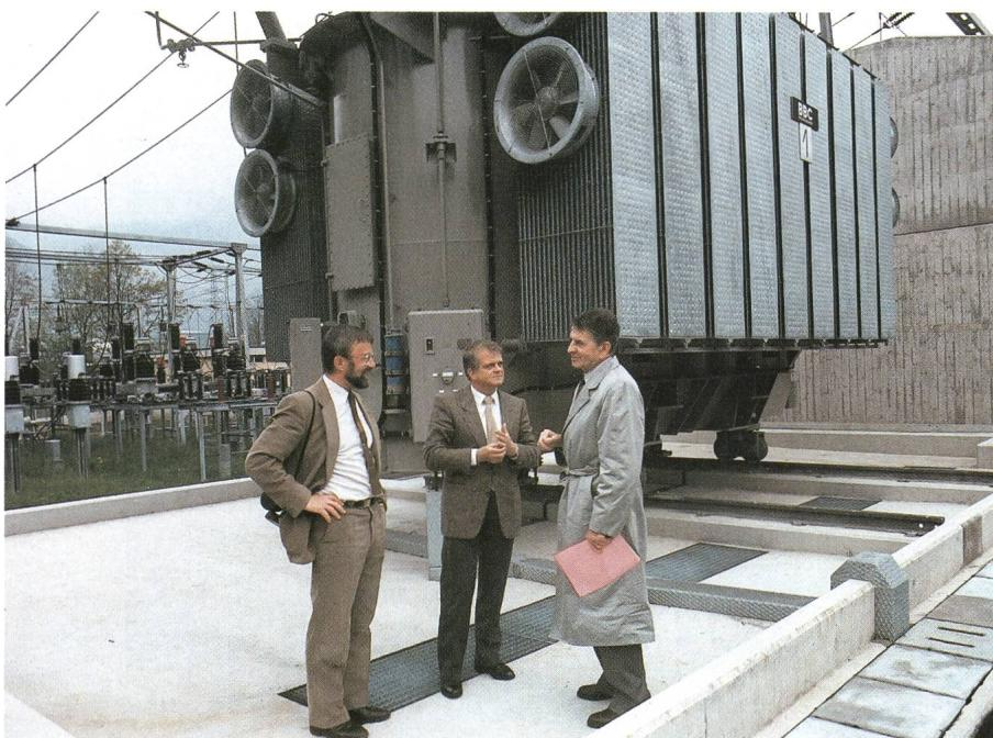
**Sous-station de Mendrisio avec deux transformateurs de 100 MVA, 150/50 kV lors de l'inspection des mesures de mise à terre par l'Inspectorat fédéral à courant fort**
