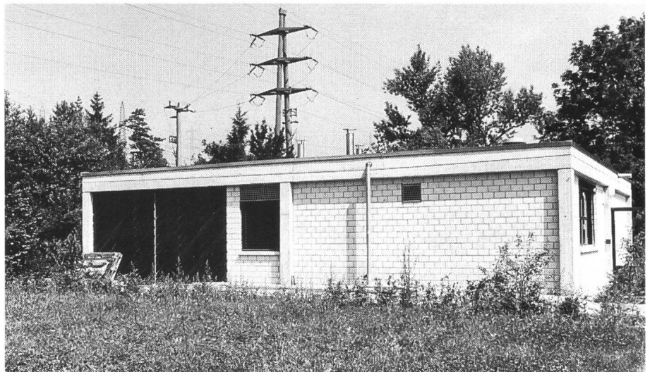
Bild 1 Wasserstoff- und Brennstoffzellen-Anlage in Niedergösgen
