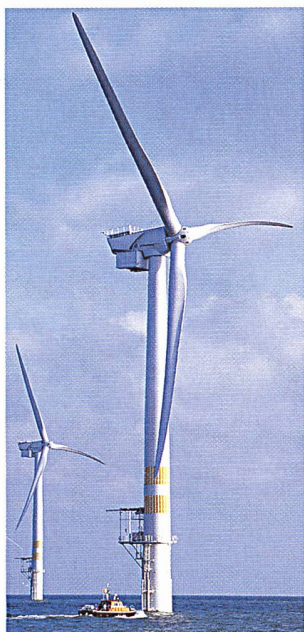
Kostspielige Netzintegration von Windenergie an Land und Offshore (3,6-MW-Windturbinen/Bild GE).
