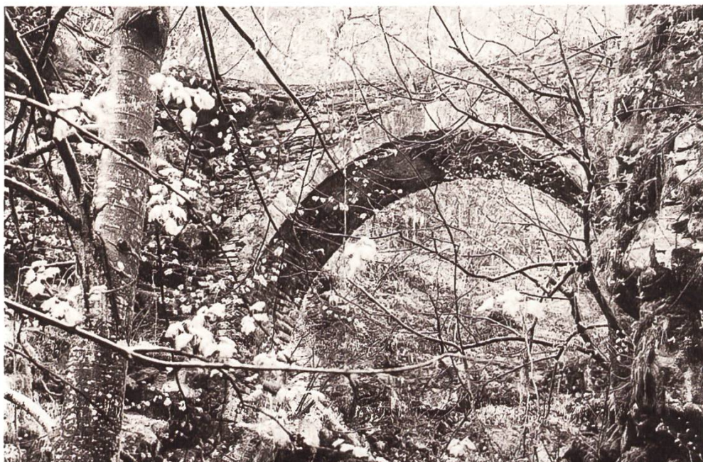
Die 1978 weggerissene Brücke über den Isorno
