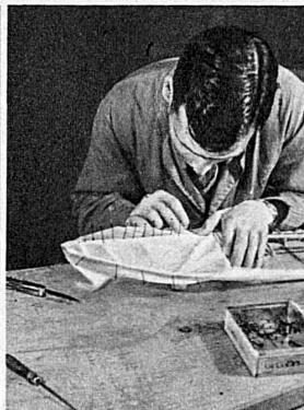
Zum Bespannen der Modelle verwendet man Seide und Japanpapier. Seide wird mit Nadeln auf das Gerüst gehetet und sodann aufgeleimt – Pour la voilure des modèles, on utilise la soie et le papier Japon. La soie est fixée à l'aide d'épingles sur le bâti, puis collée
