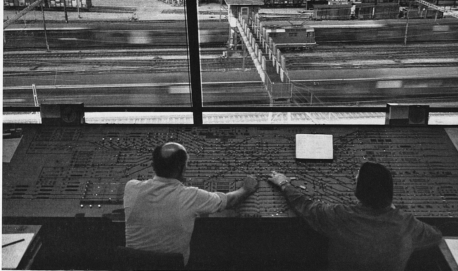
**Oben:** Im Zürcher Zentralstellwerk. Von hier wird den 880 täglich ein- und ausfahrenden Zügen der Weg gewiesen. Durch Druck auf zwei Tasten kann die gewünschte Fahrstrasse für einen Zug eingestellt werden. Weichen und Signale gehen automatisch in die richtige Stellung. Der Stelltisch enthält 985 Tasten. Photo Giger SVZ.
