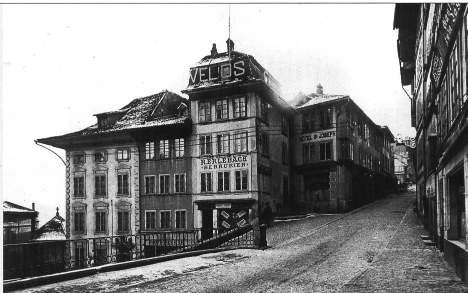
La maison de Schaller et les immeubles Dreyer-Feller, Erlebach puis l'Hôtel St-Joseph avec sa statue d'angle, démolis en 1906-1907 (ASBC, P. Macherel)
