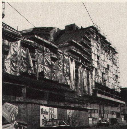
Hauptfassade des bestehenden Theaters, welches zugunsten des neuen Hauses abgerissen wird
