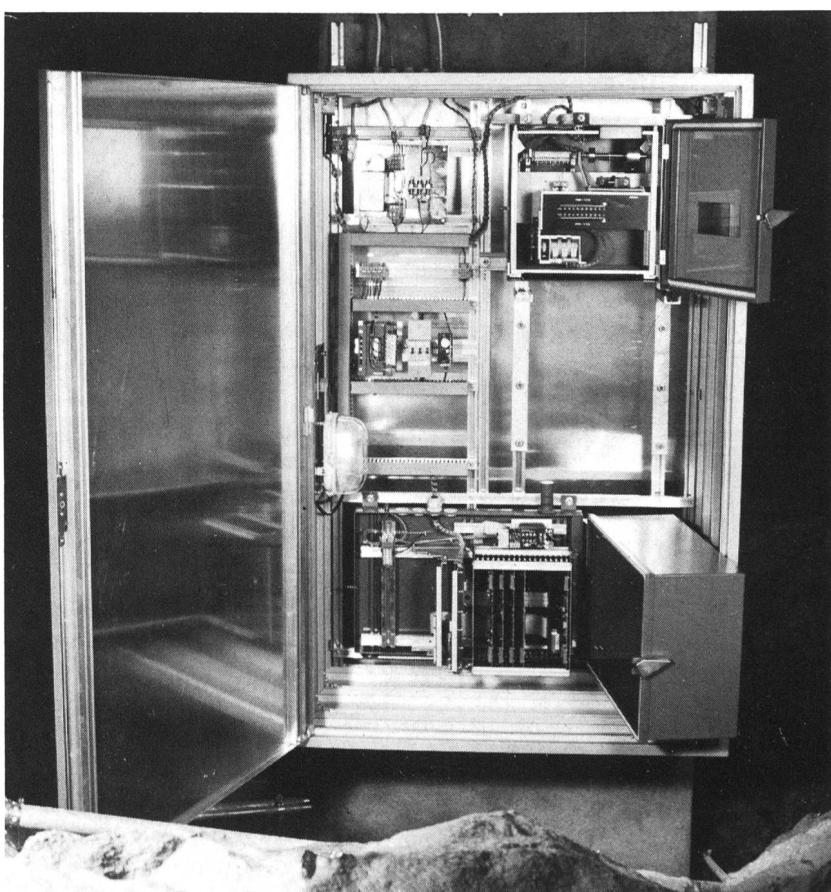
Bild 3. Über der Messstation A4 mit der Tauchstabwaage unten im Schrank befindet sich die Ridat-Anlage für die Datenübertragung.
