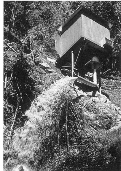
Figure 6, à droite. La Douve 2, vue de sous son débit d'eau de restitution, après returbinaje des eaux turbinées par sa grande sœur, 83 mètres en amont. «Par chance, il n'y a pas de poissons dans la Douve (c'est aussi le nom de la rivière!), parce que sinon, l'obligation de leur construire une échelle a souvent pour conséquence de ne plus rendre l'opération très rentable», reconnaît Roger Galé avec lucidité. La mise en place de la mini-centrale sur son chassis par un hélicoptère n'a duré que 28 minutes.
