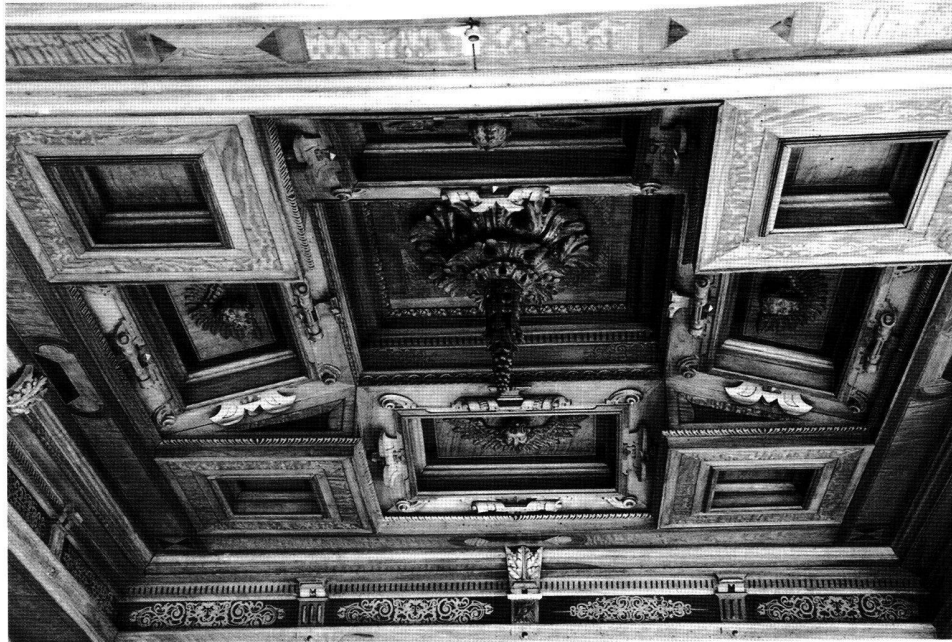
Abb. 26 Zentrale Hauptkassette der Decke.
