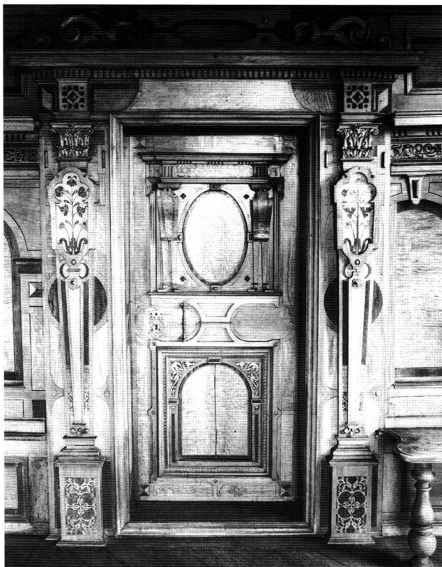
Abb. 23 Kammertür an der Westwand.
