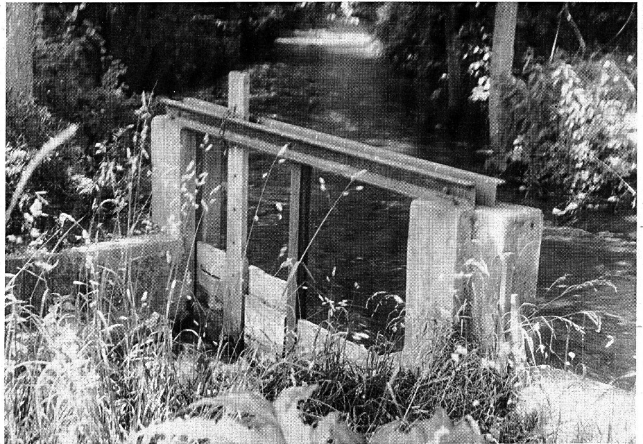
Die Wasserführung der Bewässerungsgräben — hier des Stampfbaches — wird mit Hilfe von «Brütschen» reguliert. Auf dem Bild Abzweigung vom Tych (rechts im Bild) beim Perrymarkt.
