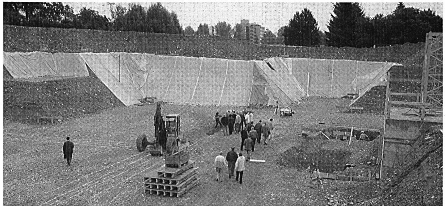
Beginn der Baumeisterarbeiten.
