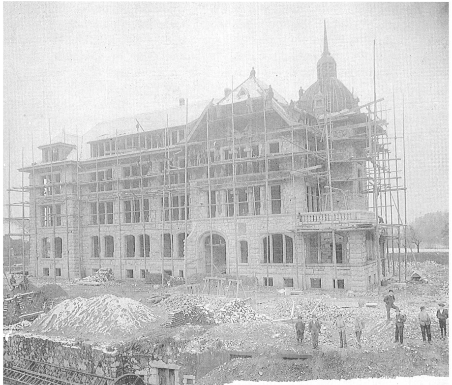
Das Gemeindeschulhaus während des Baus im Winter 1902/03. Im Vordergrund die zugeschüttete Parterrewohnung des alten Herrensipitals.
