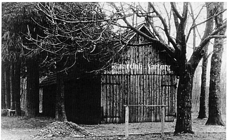
Das erste Aarburger Ruderhaus am Kraftwerkskanal Ruppoldingen. 4
