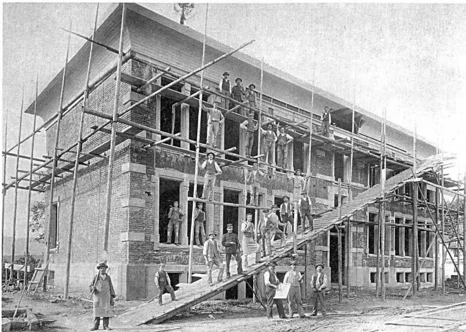
Während des Baus.
