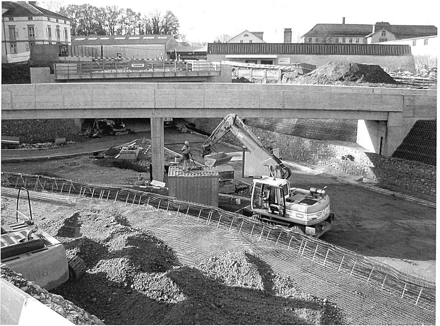
«Brücke Weber»: Die Anschlussspur Olten–Bahnhofstrasse.
