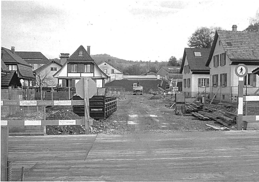
Bornstrasse im Rohbau Richtung Osten.
