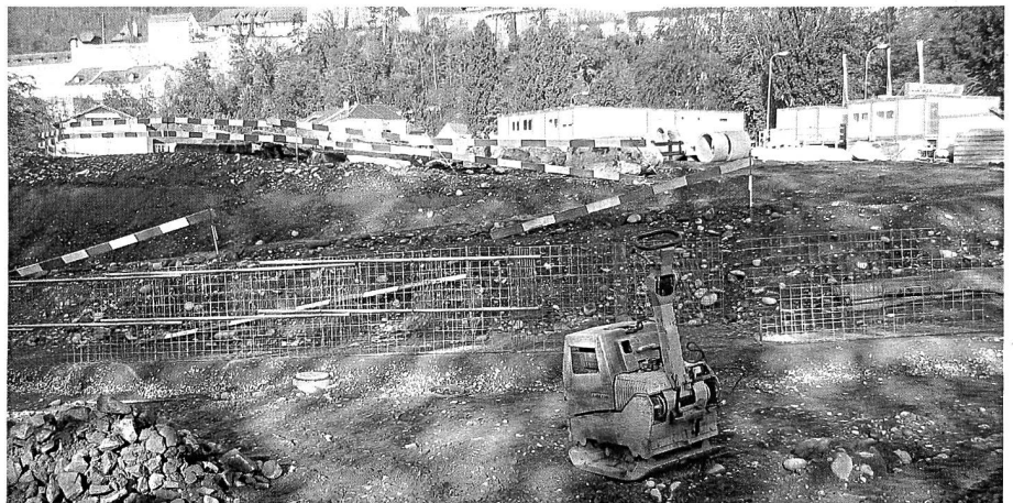
Vorarbeiten für die Steilböschung.
