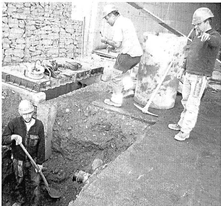
Bald eine Seltenheit auf der Baustelle: Die Schaufel.
