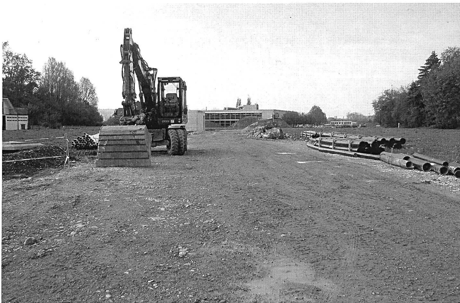
Bereits eingedeckt: Der Tunnelabschnitt östlich der MZA.
