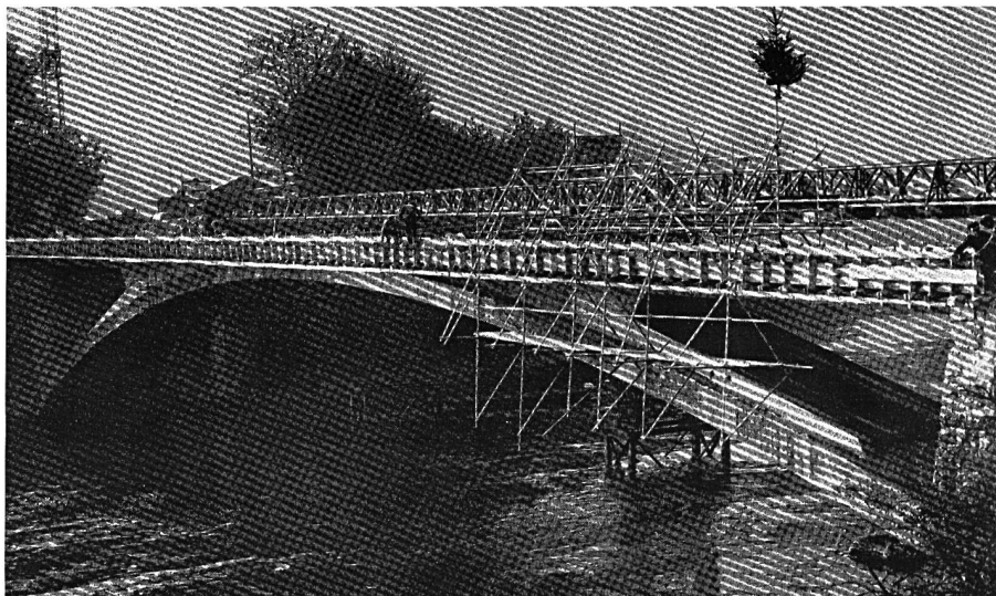
Gefährliche Arbeiten über der Aare (Umbau 1968).
