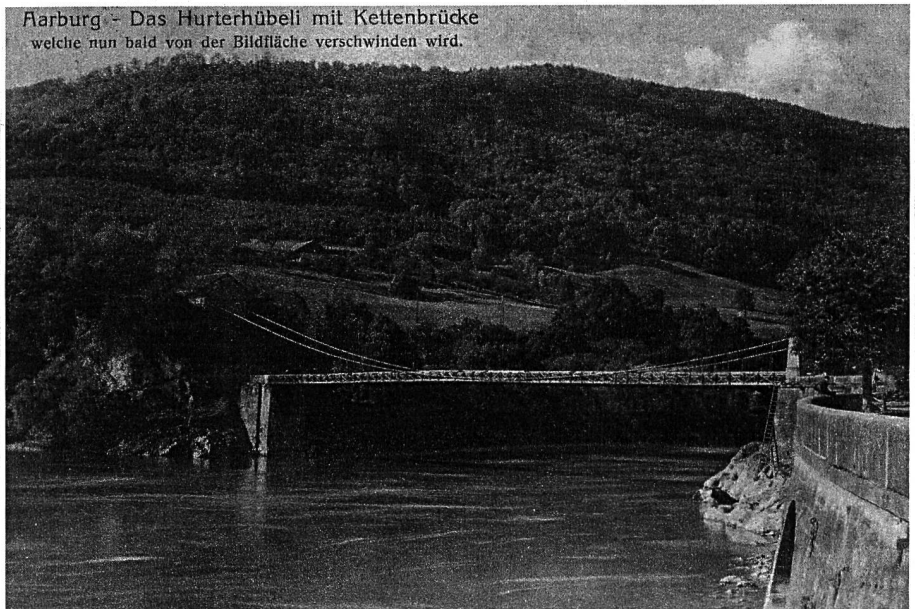
Die ehemalige Drahtseilbrücke.
