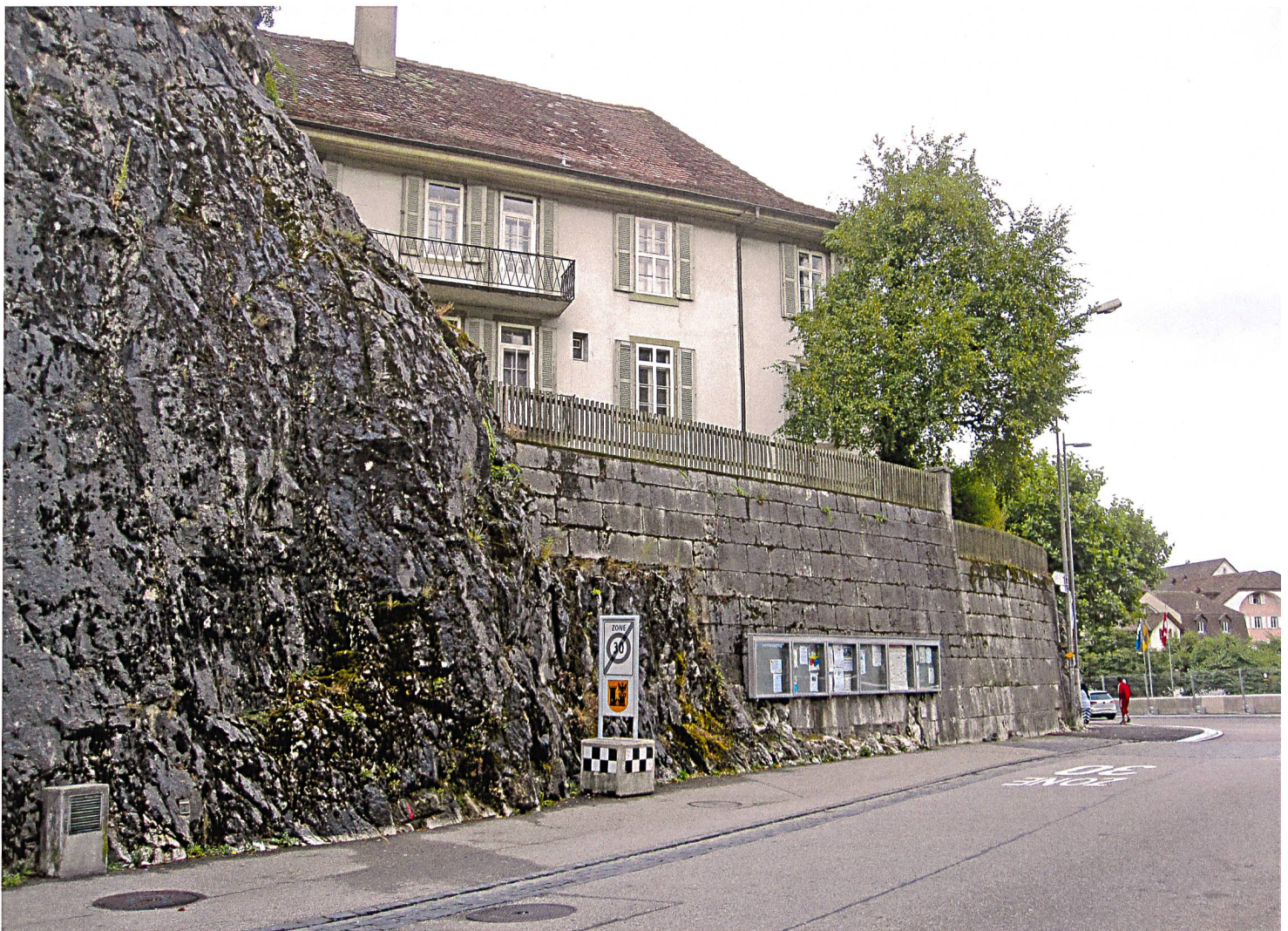
Hier schliesst die Quadersteinmauer an den Festungsfelsen an. Bei der Sprengung dieser Felspartie wurde der ominöse Sandkasten demoliert. Am Fuss der Mauer hängt bis heute der Anschlagkasten der Gemeinde. Foto: Peter Schärer, Juli 2015
