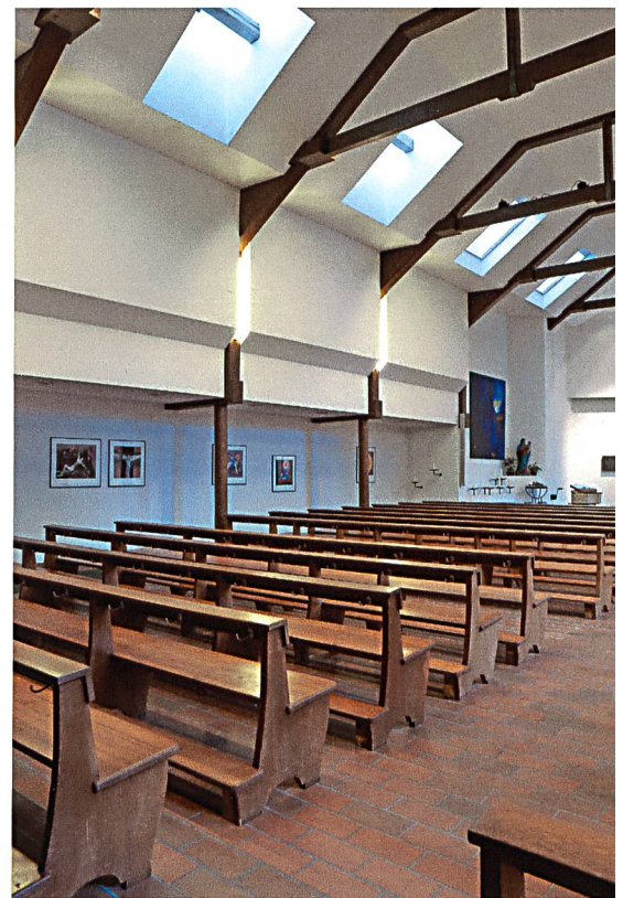
Die Fenster im Obergaden weichen schrägen Dachfenstern. Die Binder werden verschalt und durch ein Hängewerk ersetzt. Foto P. Schärer, Januar 2016.
