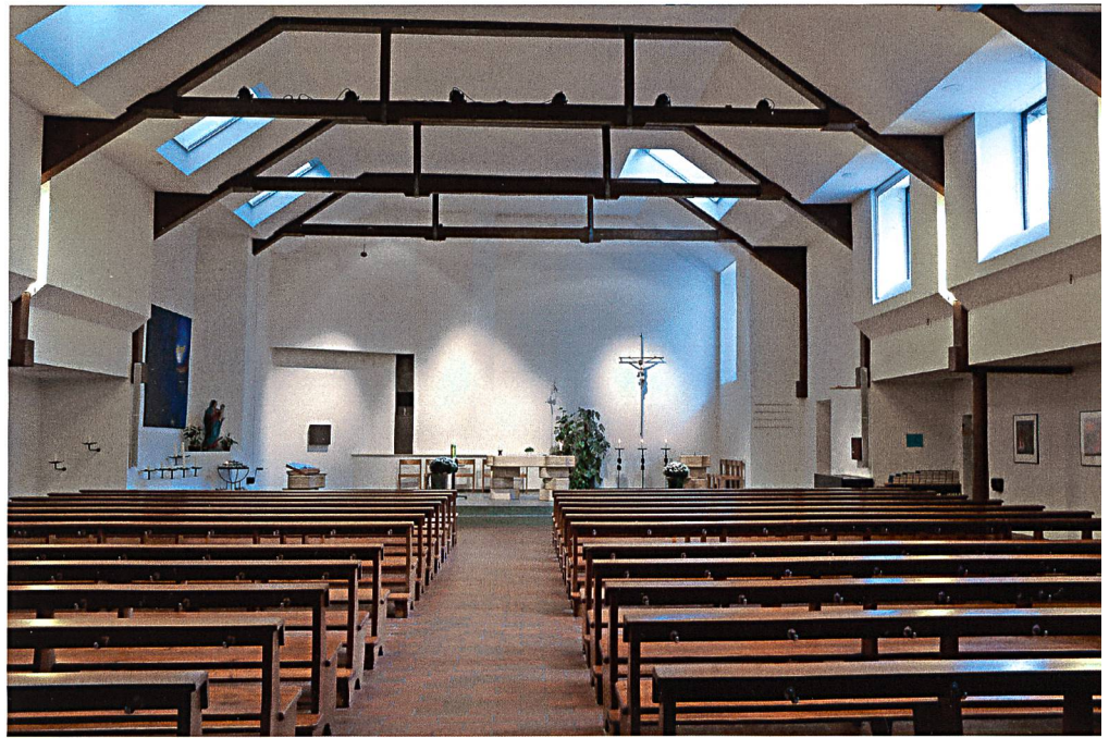
Blick in den Chorraum der 1976 renovierten Guthirtkirche, wo das einzige Obergadenfenster erhalten geblieben ist, die restlichen sind geschlossen und durch Lichteinfall im Schrägebereich ersetzt worden. Foto P. Schärer, Januar 2016.
