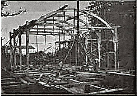
Stellen der Binder und Aufrichte des Holzskeletts der Guthirtkirche am 10. November 1941. Gedenkblätter.
