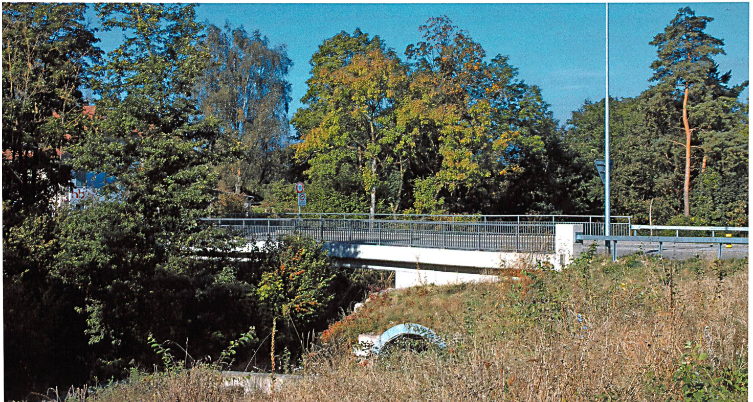
Die Wiggerbrücke im Aeschwahr («Vierländereck» Rothrist, Strengebach, Zofingen, Oftringen) wird bereits 1440 erwähnt. Sie war jedoch keine «Hauptstrasse», sie diente lediglich dem «Lokalverkehr». KBZ
