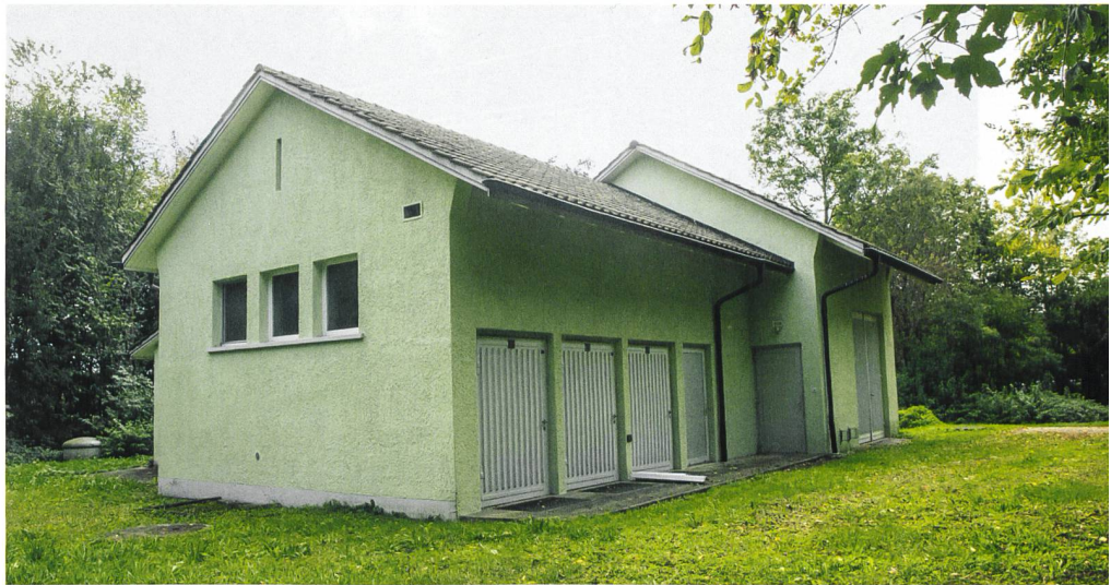
In diesen Gebäuden ist das Pumpwerk Paradiesli untergebracht.
