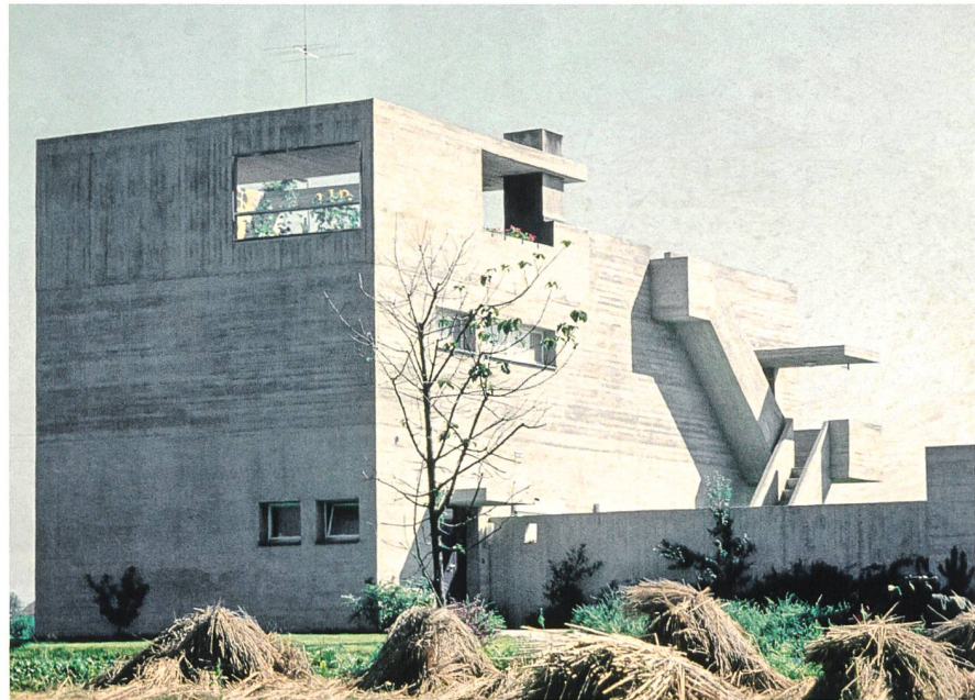
Nord- und Westfassade. Rechts der mit dem Haus durch eine Sichtbetonmauer verbundene Garagenbau. (Historische Fotografie: ©Archiv Atelier 5)
