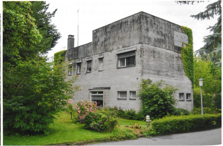
Ost- und Nordfassade. (Foto 2018: ©Kantonale Denkmalpflege Aargau)
