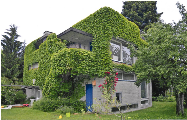
West- und Südfassade. (Foto 2018: ©Kantonale Denkmalpflege Aargau)
