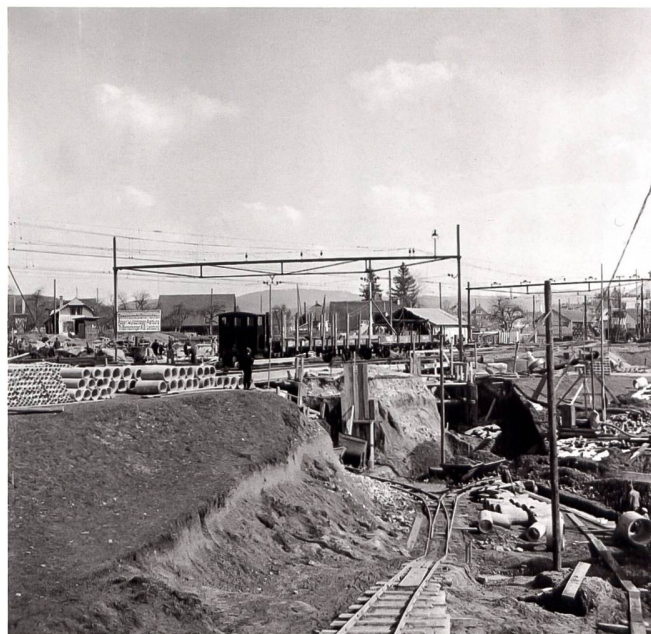
Für die damalige Zeit ein vertrauter Anblick einer Baustelle, für uns heute kaum mehr vorstellbar: Harte Handarbeit mit Pickel, Schaufel, Rollwagen unter Einsatz von Muskelkraft und Schweiß. Foto Archiv SBB Historic
