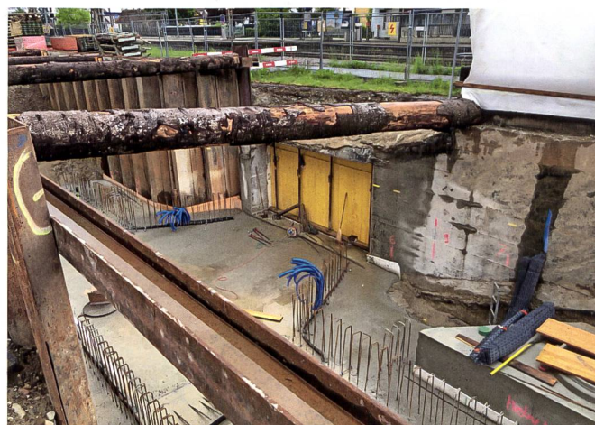
Anschluss an die Unterführung (Mai 2021).
