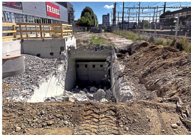
Abbruch alte Unterführung (September 2021).
