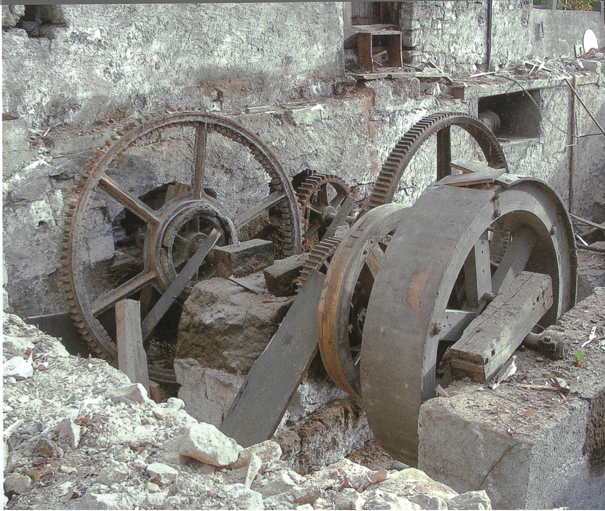
Bubendorf, Hauptstrasse 63. Zahnräder, Wellen und Riemenscheiben – Teile des Getriebes der Sägerei während des Abbruchs.
